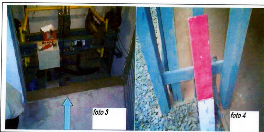
Figura 27: Madeira que caiu na caixa de corrida
