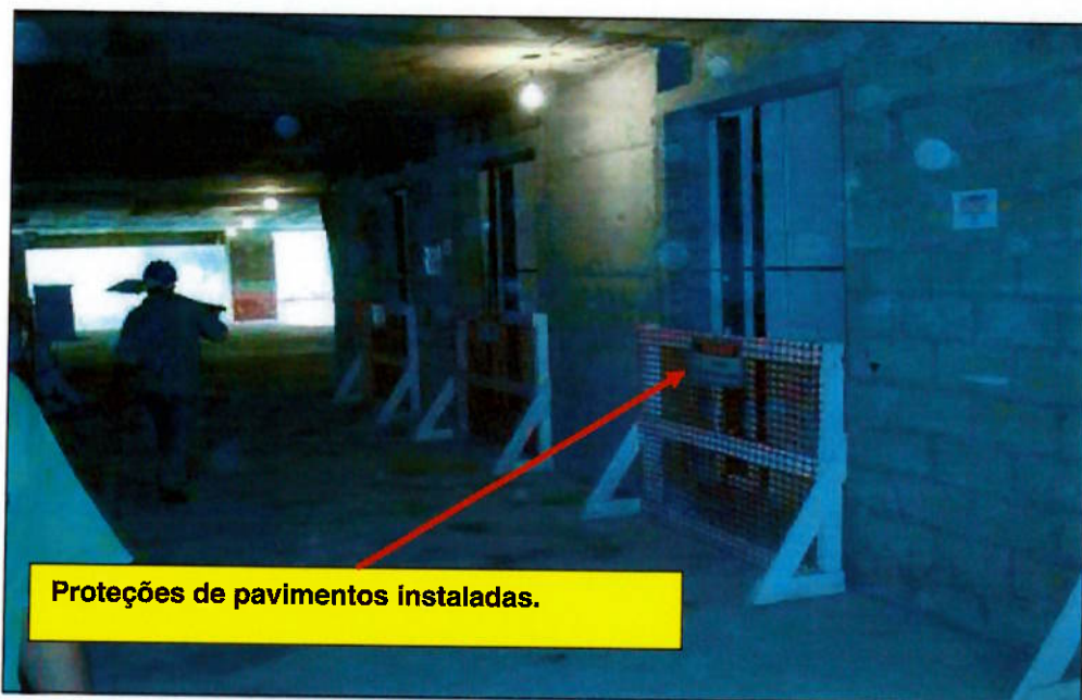
Figura 4: Sinalização e limpeza do local
