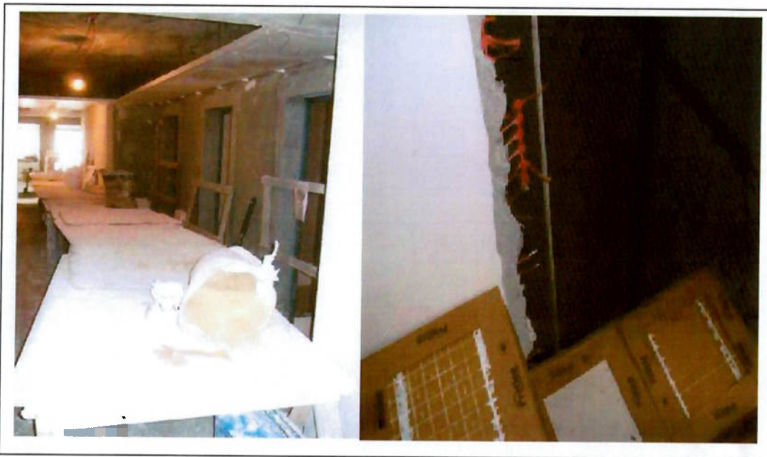
Figura 38 – Trabalho próximo das portas do elevador
