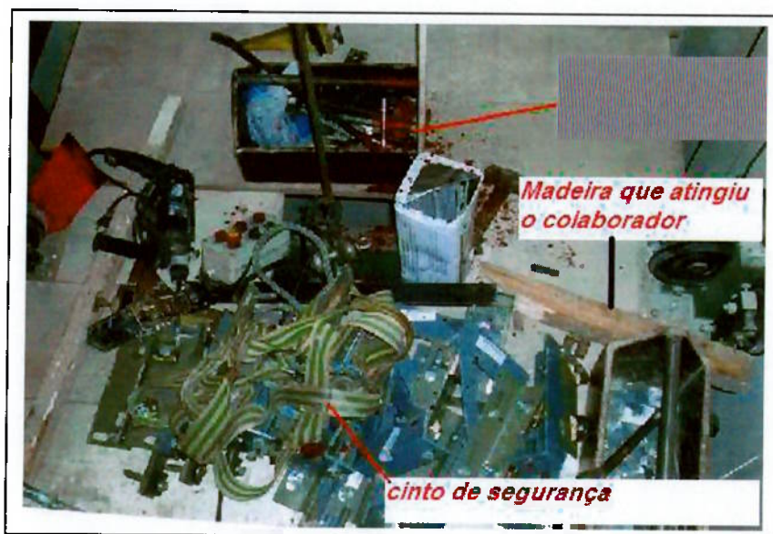
Figura 31: Local onde o montador estava trabalhando
