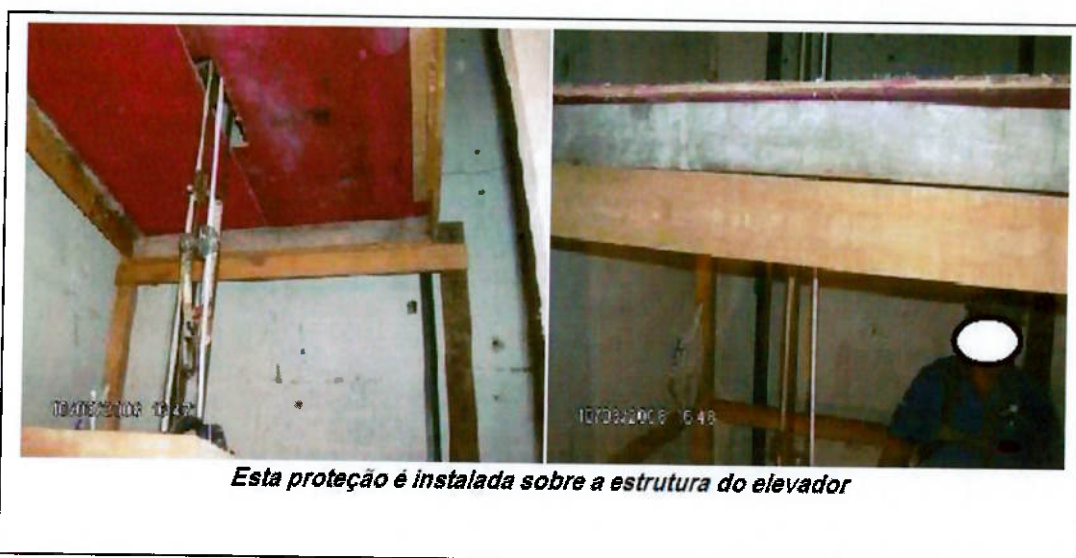
Figuras: 22 - local de trabalho dos montadores com a proteção instalada.
