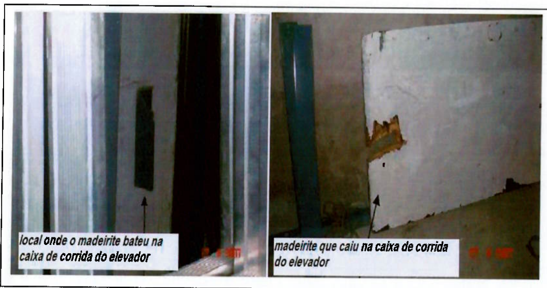
Figura: 29 Madeirite que caiu na caixa do elev.
